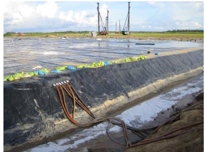
Fig. 12 Application sur site de consolidation atmosphérique
