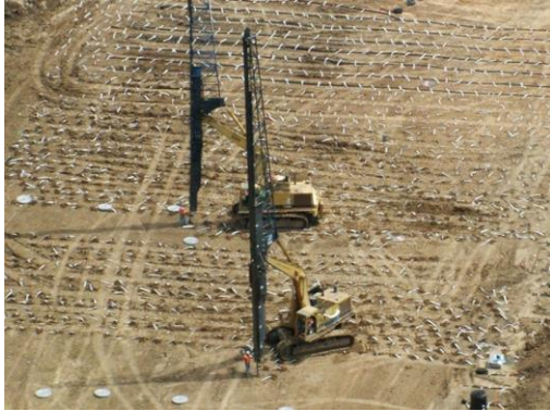
Fig. 9 Photo de l'installation des drains verticaux
