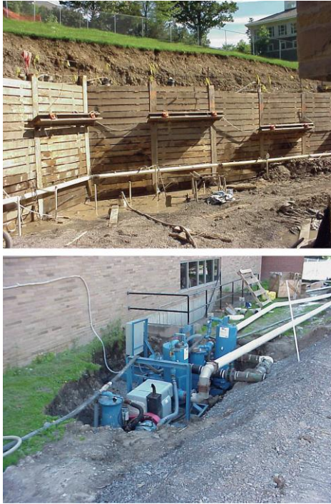
Fig. 2 Application de point filtrant et pompe pour une excavation du bâtiment, l'Université Colgate, New York
